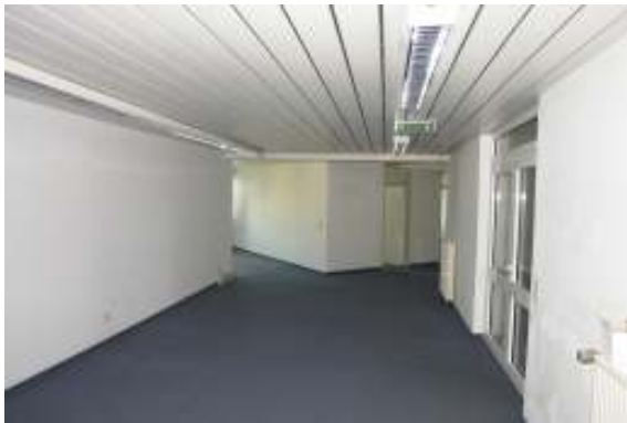
Eingangsbereich Büro 4. OG vom Treppenhaus
