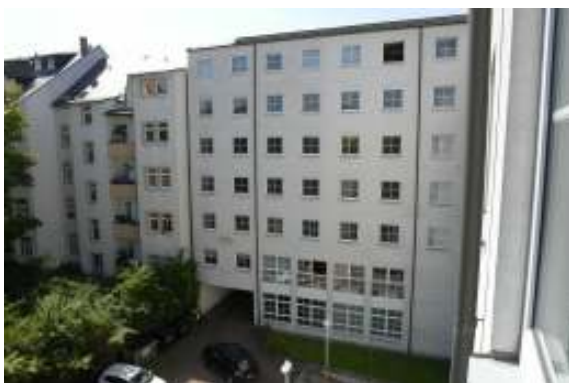
Gebäudeflügel Süd; Ansicht rückwärtig, mit Durchfahrt von der Y-Straße
