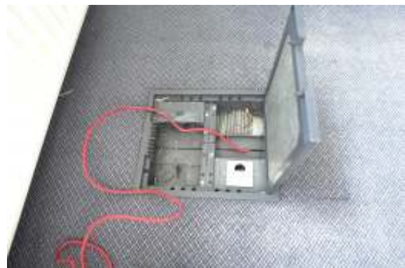
Kanäle für Unterflurinstallation
