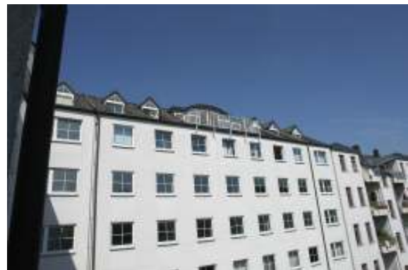
Gebäudeflügel Ost; Ansicht rückwärtig, mit Gauben und Dachterrasse zum 7. OG (2. DG)
