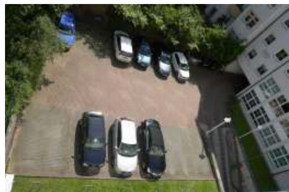
Innenhof mit Kfz-Stellplätzen und Rampe der Tiefgarageneinfahrt
