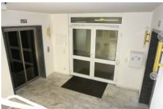
Treppenpodeste in den OG mit 2x Aufzug und Abschlusstür der Büroebene
