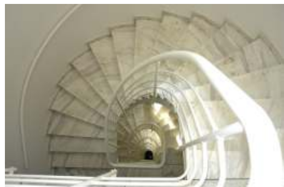
Geschosstreppe; Blick vom 7. OG (2. DG)
