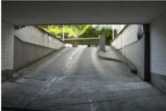
Rampe der Tiefgarageneinfahrt
