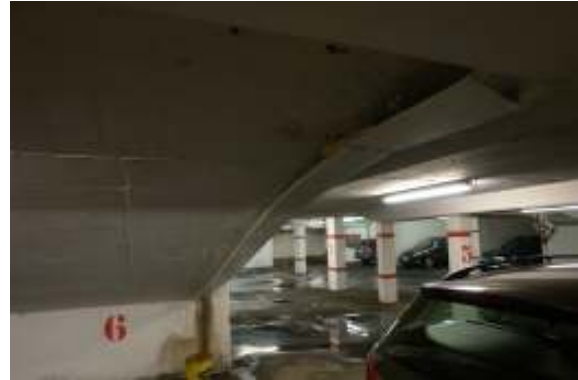
Rampenunterseite mit untergehängter Rinne; Hintergrund: Parkbereich stehendes Wasser
